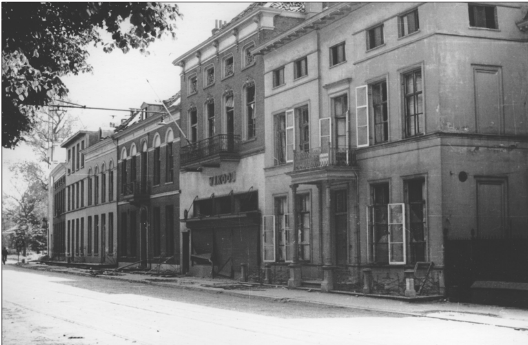
Schade aan de panden Jansbinnensingel 21 t/m 27 naast Trijssenaars pand
