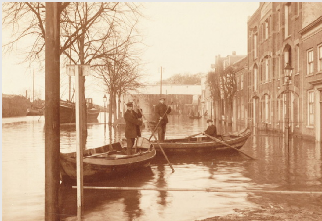
afb. 21. Overstroming van de Eem op de Grote Koppel.
