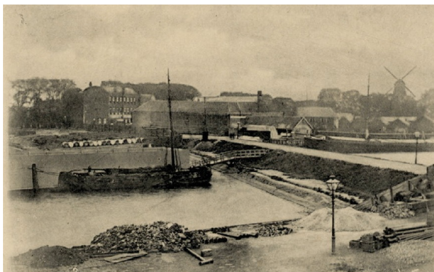
Afb. C5 Ansichtkaart uit 1900. De Oostkousdijk, gezien vanaf de Ruige Plaat. Links van de dijk de Middenkous, rechts op de achtergrond de oude houtloodsen van Van de Wetering aan de Westzeedijk.
