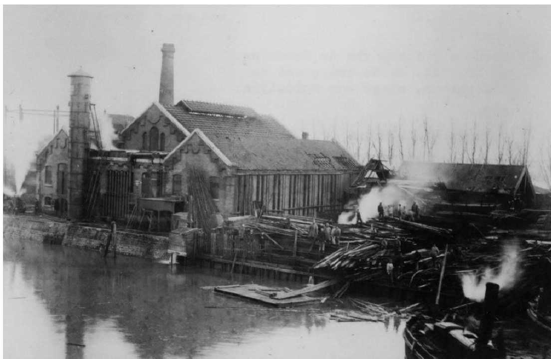
Afb. C7 De vestiging aan de Oostkousdijk, vlak na de brand op 18 maart 1896; op de voorgrond de Middenkous. Het stenen gebouw en de schoorsteen van de stoomzaagmachine staan nog wel overeind.
